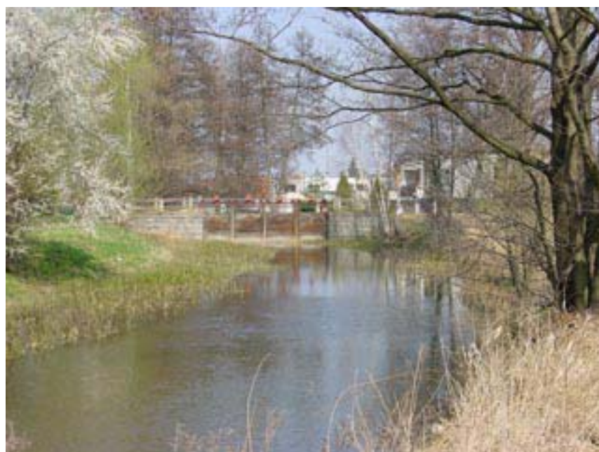
Obr. 5: Hradidlo na mlýnské stoce, kterým se reguluje množství protékané vody.
